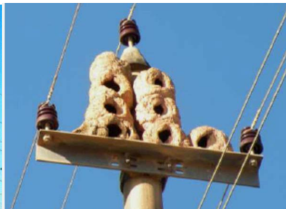
Рис. 7. Птичьи гнёзда на траверсе опоры распределительной линии
